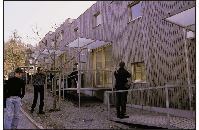
Gevelbekleding zonder dakoversteek is blootgesteld aan weer en wind
