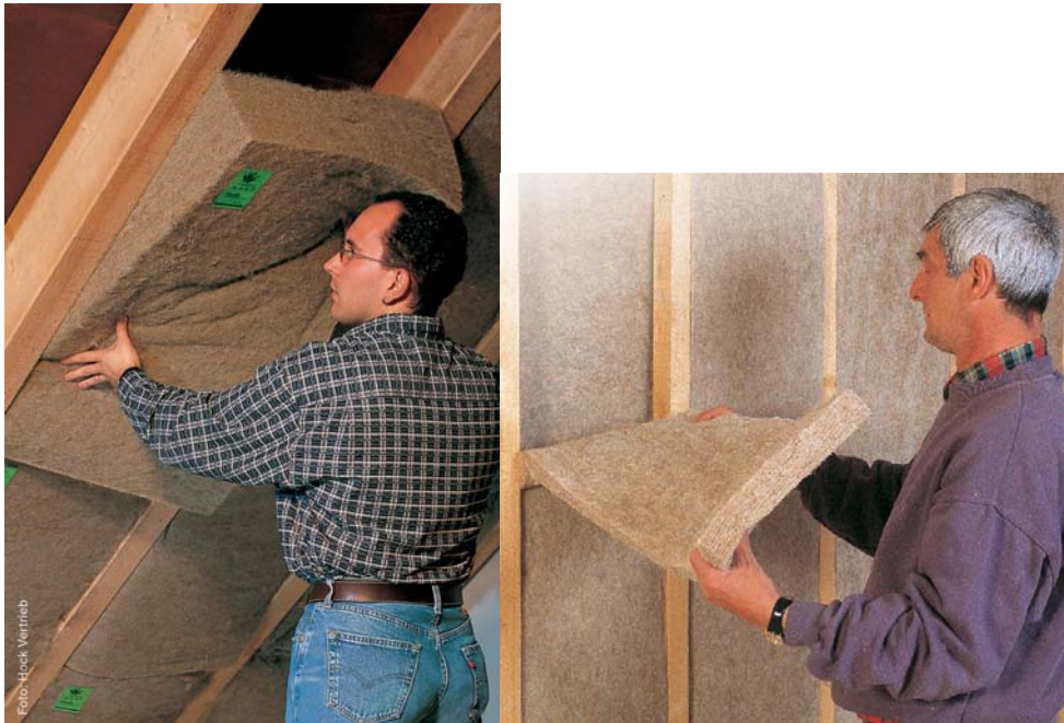
Aanbrengen Thermohanf als dakisolatie / isolatie binnenmuur
