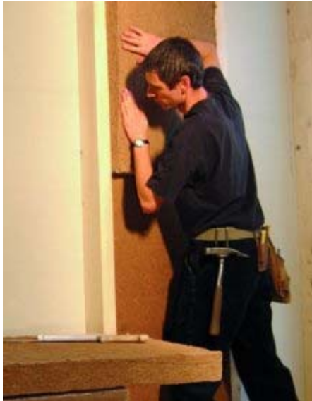
Aanbrengen Canaflex als isolatie binnenmuur
