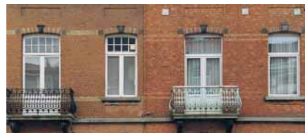
1. Venstervleugels met PVC-roeden. 2. Woning rechts: dwarsregel zonder welving, weglating van glasroeden, één enkele vleugel...
