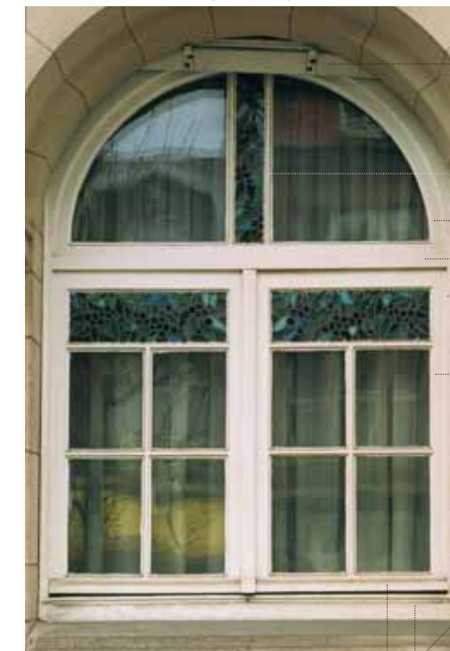
Venster met twee bewegende vleugels en vast bovenlicht
