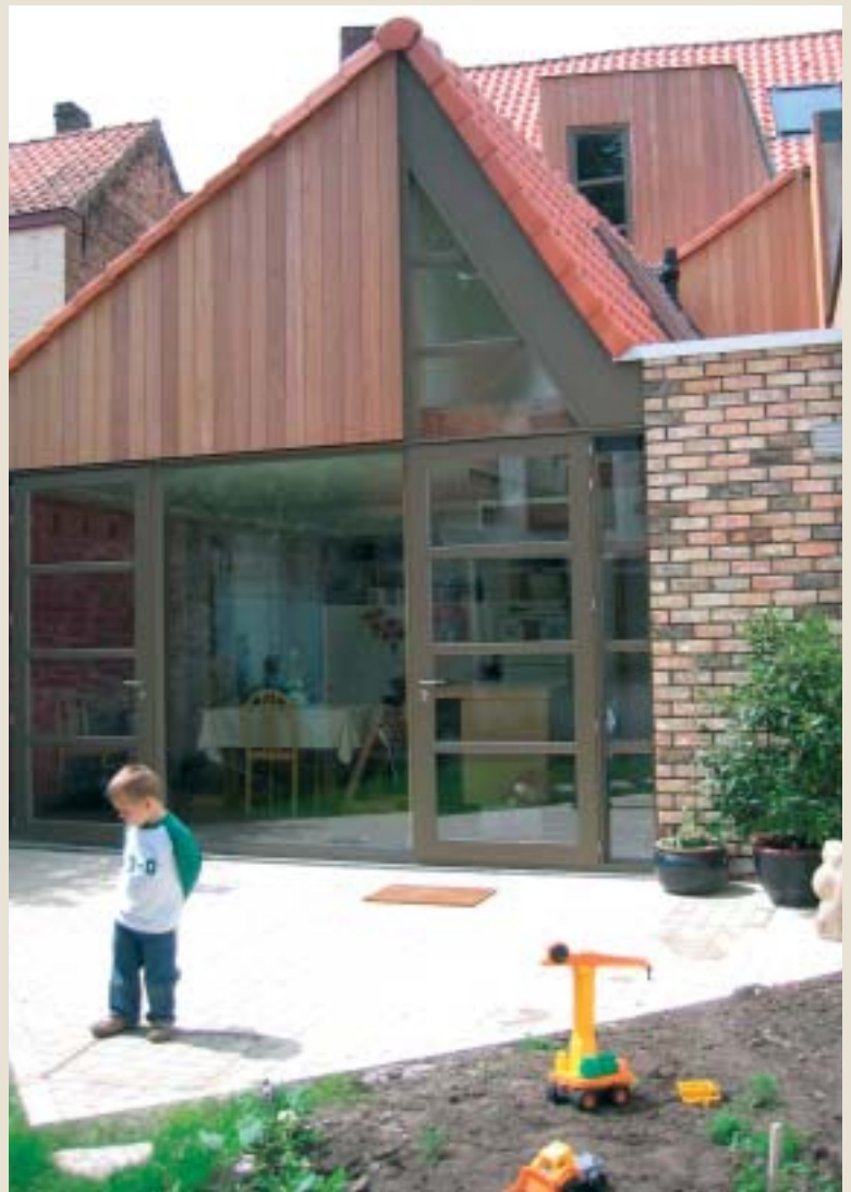
De nieuwe uitbouw is opgetrokken in houtskelet en het dak is geïsoleerd met papiervlokken. Het uiteinde van de nieuwbouw bestaat uit een grote raampartij en twee gemetselde muurtjes. Foto Emmy Vandenbosch
