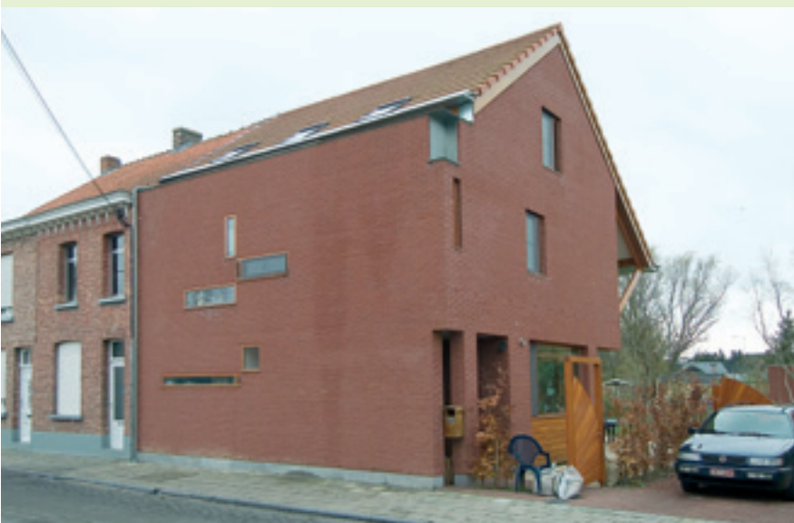
De voorgevel vormt een massieve buffer tegen geluidsoverlast. Foto CESART Jan Van Deuren.
