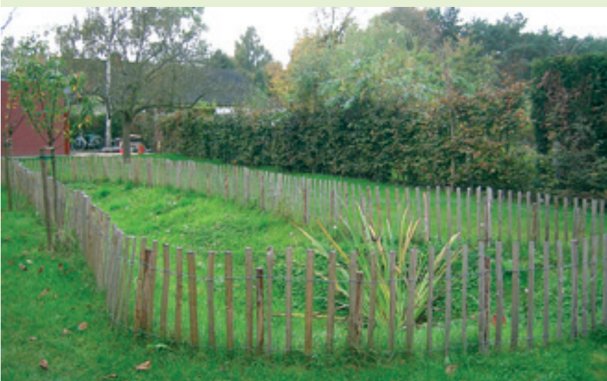
Een wadi, Water Afvoer Door Infiltratie. Foto VIBE.
