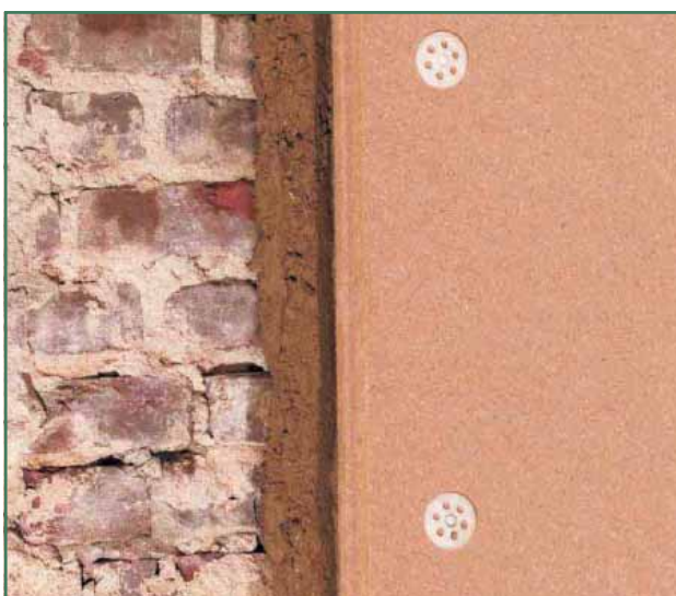
Na-isoleren aan de binnenzijde met leem en houtvezelisolatieplaat. Bron: Pavatex
