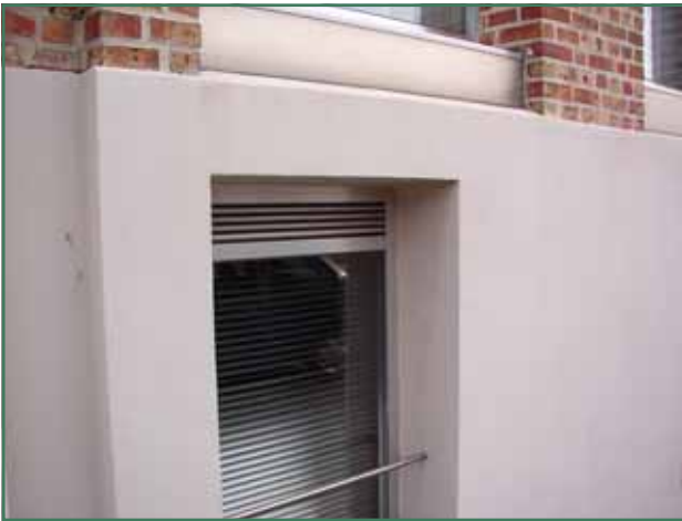
Een ventilatierooster zorgt voor de dagelijkse luchtverversing. Bij extreem grote mufheid moet je echter een raam kunnen openen (bron: VIBE).
