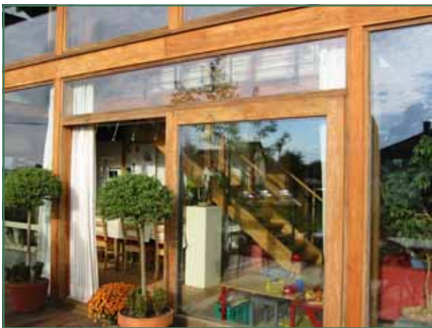
Houten buitenschrijnwerk kan je om technische redenen best schilderen of beitsen. Kies een houtsoort met duurzaamheidsklasse I, II of III: verduurzaming wordt dan overbodig. Op de foto zie je een oregon raam (architect: Peter Vos).
