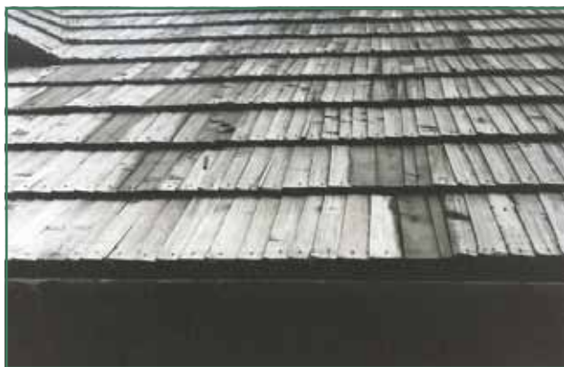
Houten shingles als dakbedekking.
