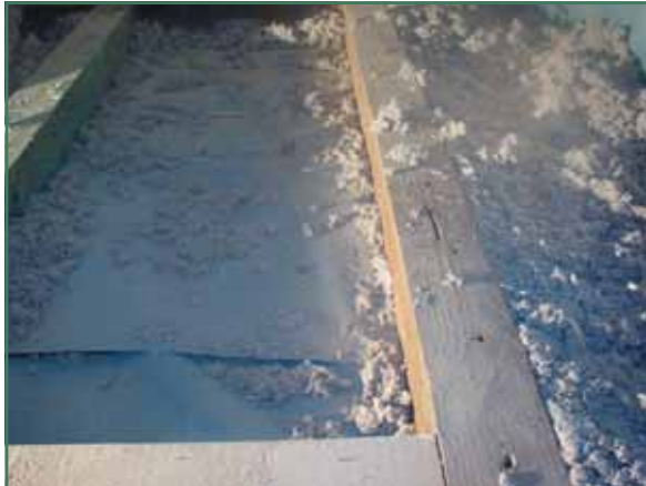
Een zoldervloer die met papervlokken is geïsoleerd. Bron: Boomer
