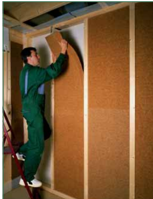
Een voorzetwand geïsoleerd met houtvezelplaten. Bron: Homatherm
