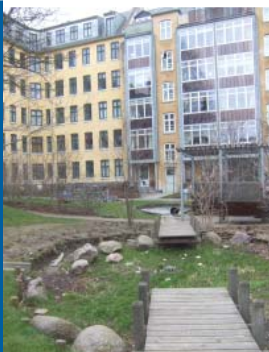
In Hedebygade stroomt het regenwater afkomstig van de daken in open goten naar een wadi, waar het in de bodem kan infiltreren. Foto Eveline Hepp
