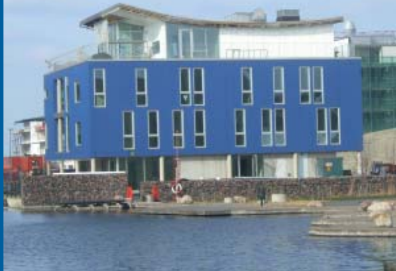
Duurzaam bouwen en esthetisch verantwoorde architectuur kunnen samengaan. Foto Eveline Hepp
