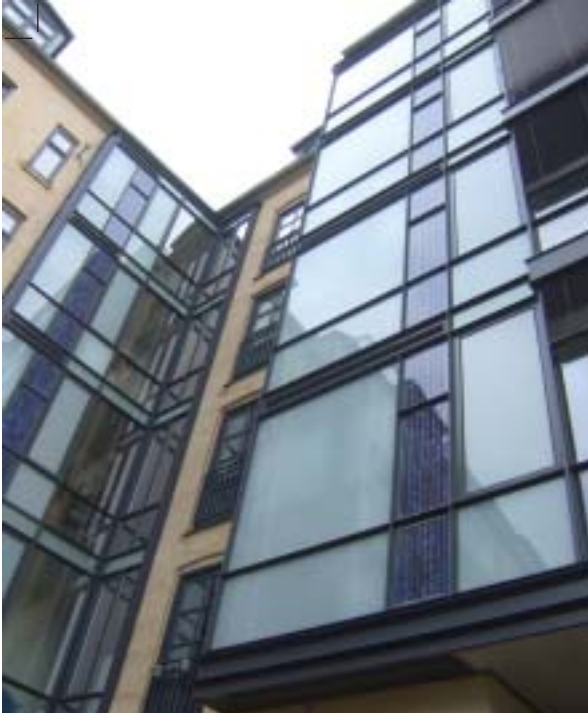
Om ruimte te besparen in de appartementen werden de technische installaties achter een glazen wand voor de gevel geplaatst. Foto Eveline Hepp
