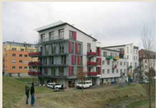
Zowel aandacht voor energie als water komen tot uiting in dit 'nulenergie' passiefgebouw met beekvallei. Foto Guy Dries
