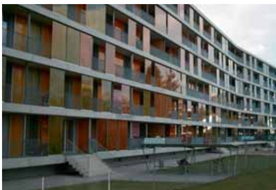
Het MINERGIE-ECO-gebouw Brunnenhof krijgt kleur door gele, oranje, rode en blauwe verschuifbare zonneschermen. Foto VIBE vzw
