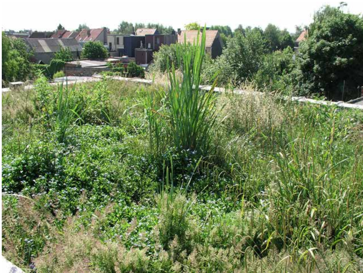
Groendaken bufferen regenwater en brengen verkoeling in de stad. Wie een groendak aanlegt, kan in sommige steden en gemeenten een premie krijgen.
