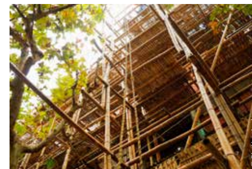
In China trekken bouwvakkers nog steeds metershoge stellingen op in bamboe.
