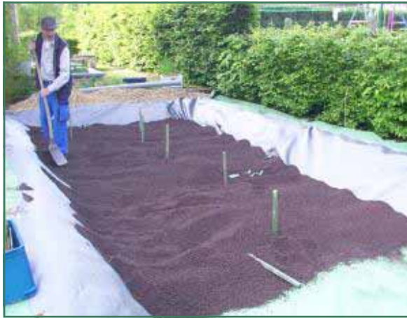
Het filtermateriaal wordt aangebracht op de folie Bron: B&B NV - Pure
